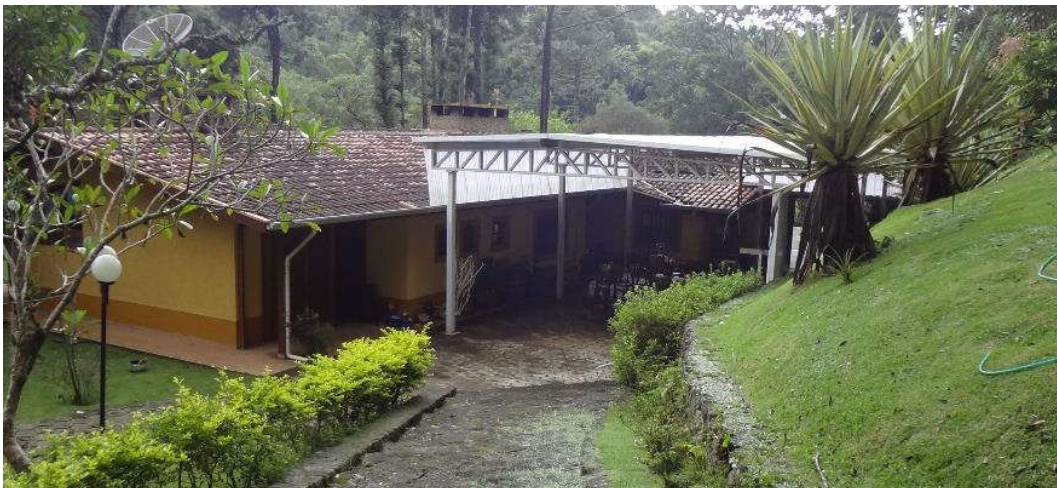
Figura 6 – Vista dos fundos da Casa Principal.
