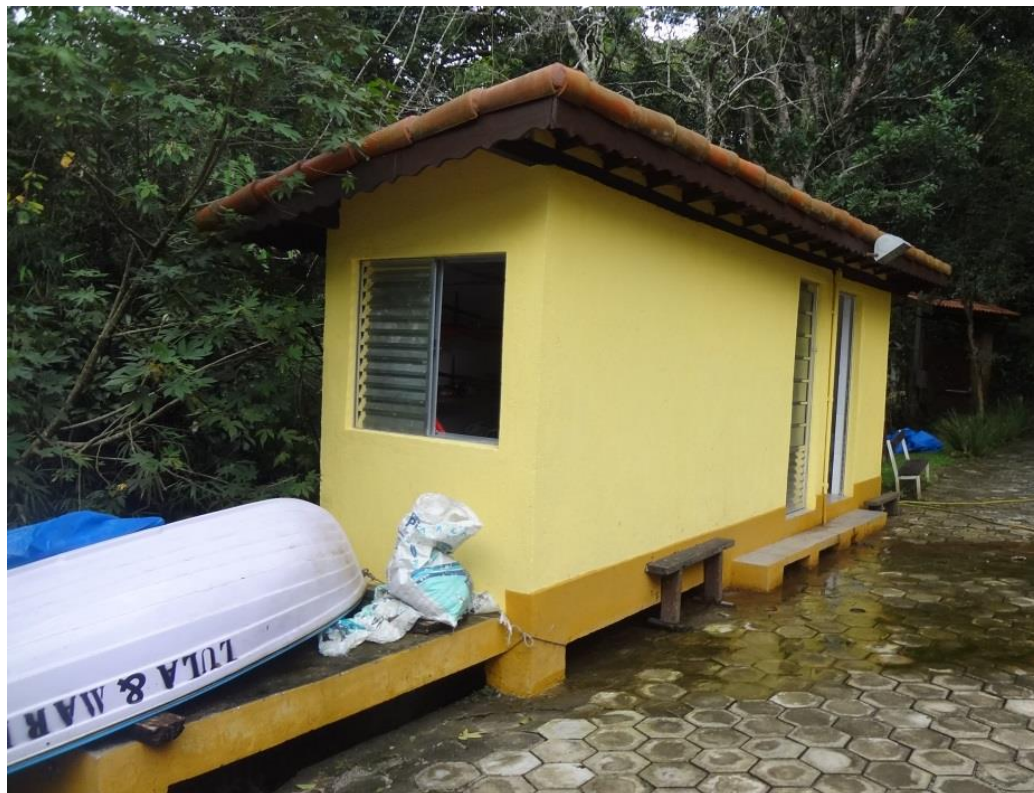
Figura 33 – Vista geral da Casa de Barco.
